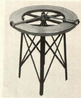
Der Askania-Kreisrechenschieber zur schnellen Lösung schwieriger mathematischer Aufgaben
